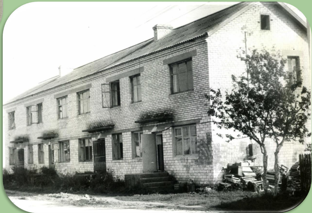
Жилой дом в деревне Новая Деревня для работников совхоза
